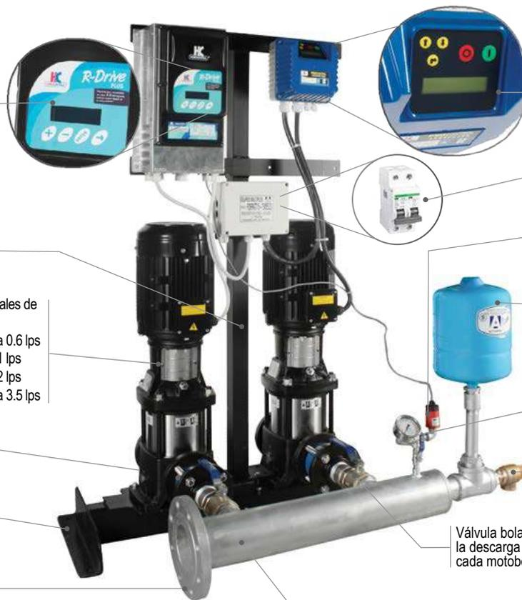
Ensamblado con motobombas verticales de alta calidad ALTAMIRA SERIE TX:
